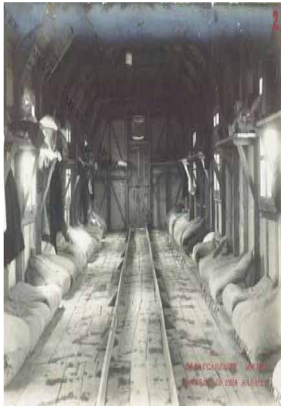
Baraccamento operai. Interno di una baracca, 1916, Museo Centrale del Risorgimento.
