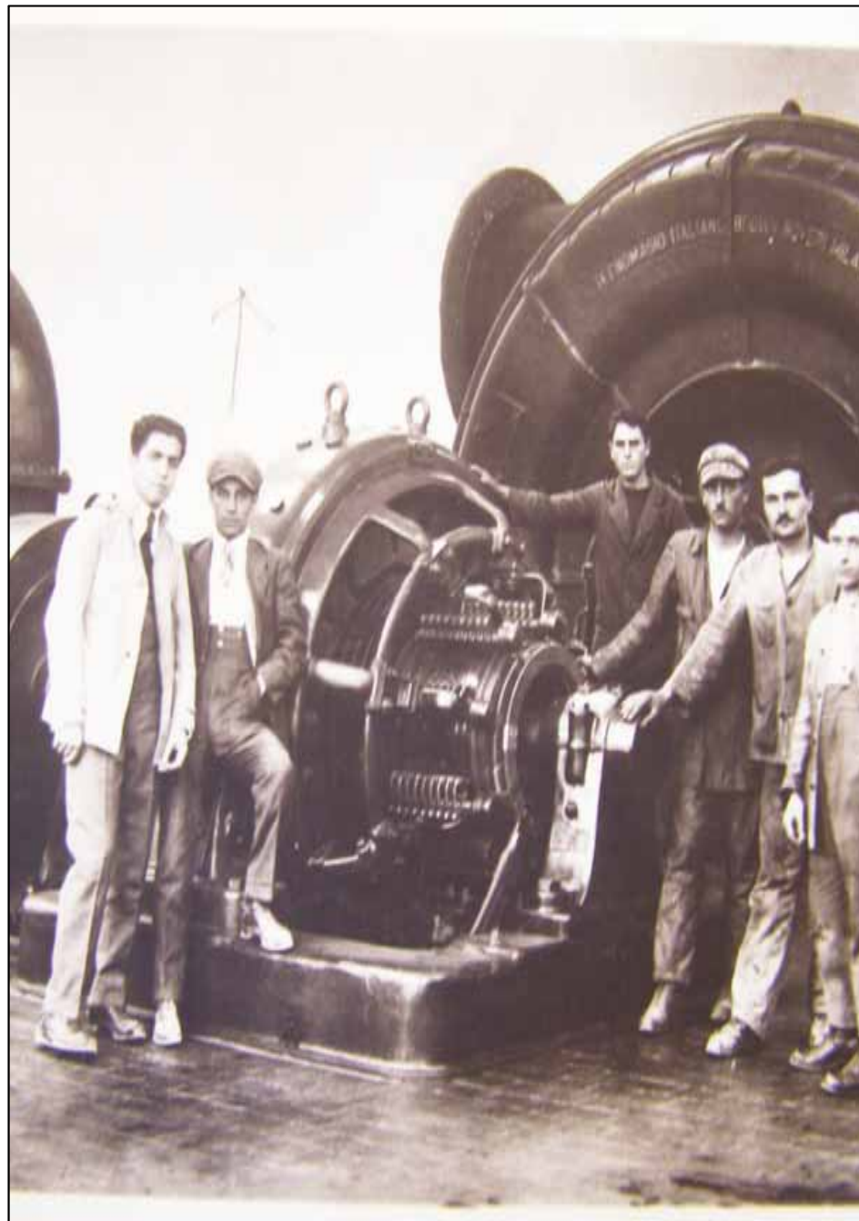
Inaugurazione della Centrale di Nera Montoro, 1915.
