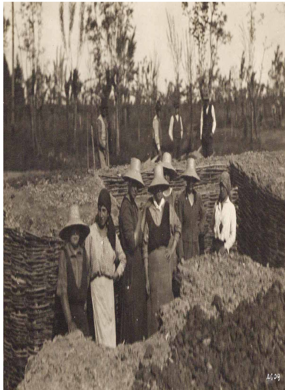
Operaie adibite a lavori di trincea, 1917.
