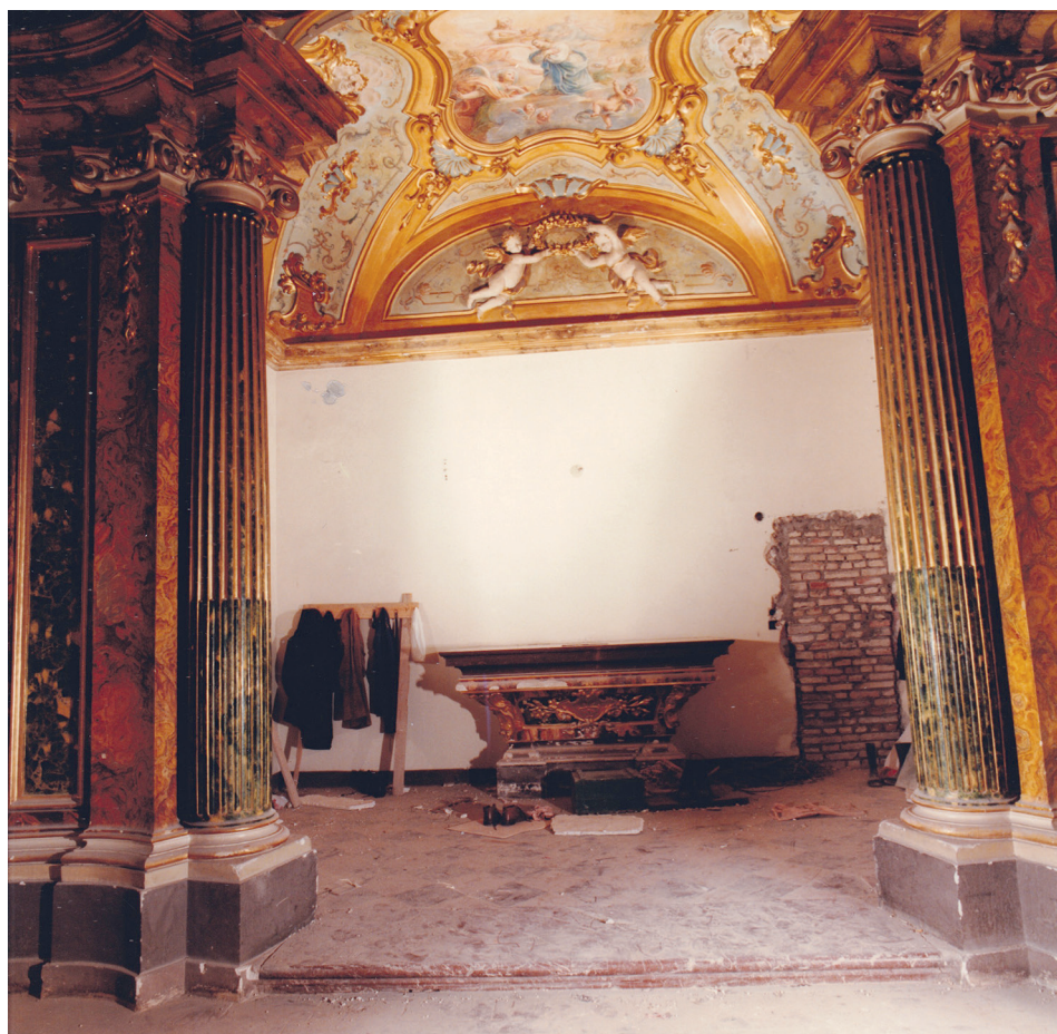
Palazzo Donini, la cappella della famiglia prima dei lavori di ristrutturazione (Archivio Salvatici-Ripa di Meana).
