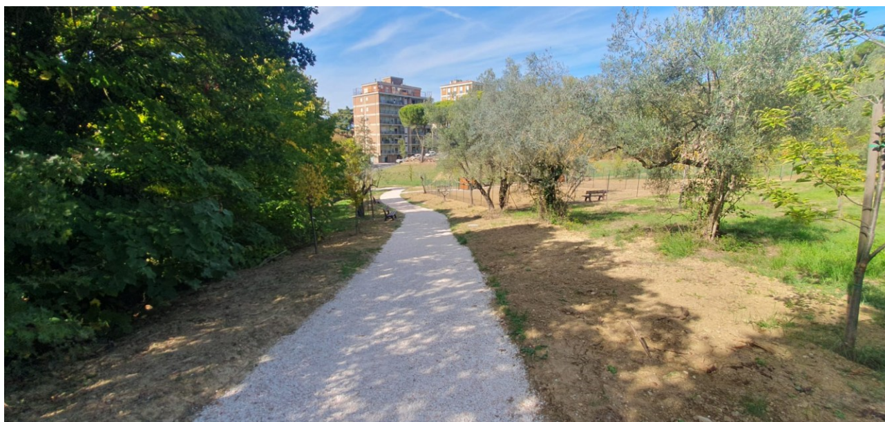
Foto 2 - Lavori di riqualificazione parco urbano via S. Pellico - Perugia
