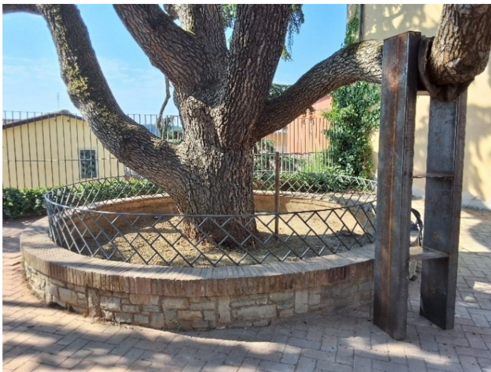
Foto 13 - Sostegno in Cor-Ten Cedro Porta Pesa – Perugia
