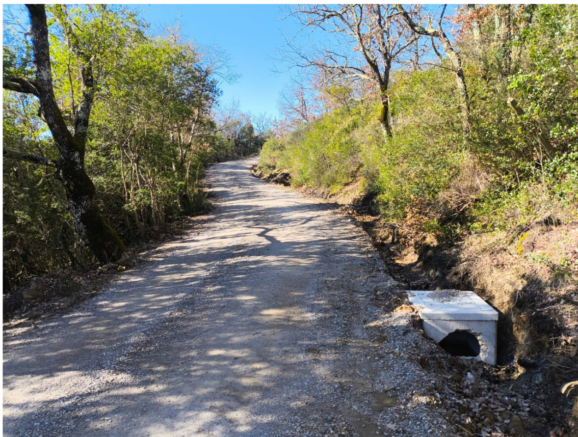
Foto 3 - Regimazione delle acque meteoriche – Str. di Casaglia – S. Venanzo
