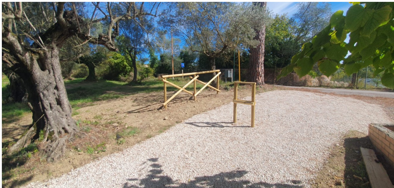
Foto 1 - Lavori di riqualificazione parco urbano via S. Pellico - Perugia
